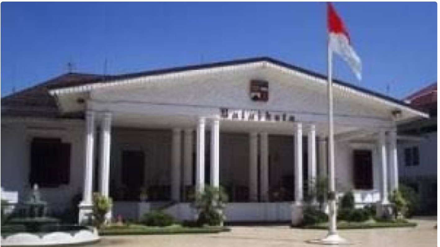
Photo Gedung Wali Kota Bogor
